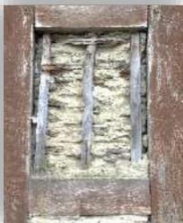
**1.** Entre les poutres, un **tressage de branchages** et autres tasseaux assurent une base solide sur laquelle est appliquée le torchis.
