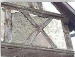
**3.** Le torchis, pour être protégé, est recouvert d'un **enduit à la chaux**.
