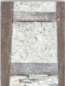
**2.** Le **torchis** : masse de terre argileuse mélangée à de la paille puis appliquée et lissée à la main. Cette ancienne technique s'avère être un excellent isolant en hiver et un régulateur de température en été. Le remplissage se faisait également avec des briques.
